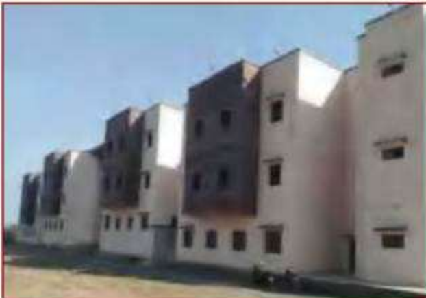
प्रयास आवासीय विद्यालय, बिलासपुर का नवनिर्मित भवन
